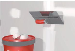
In den folgenden Arbeitsschritten wird je nach gewünschter Oberflächenqualität die Fläche entsprechend gespachtelt. Nach vollständigem Abtrocknen kann bei Bedarf geschliffen werden.
