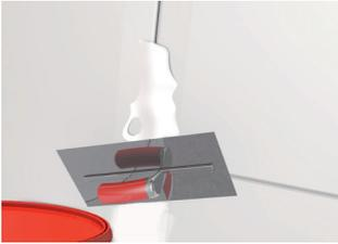
Beim Verspachteln der Gipsplatten mit Fugendeckstreifen wird der Spachtel (z.B. DANO® PASTÖS LEICHT oder DANO® FÜLL UND FLÄCHE) mittels Glättkelle oder Spachtel flächenbündig in die Längs- und Querfugen eingezogen, bis die Fugen vorgefüllt sind.
