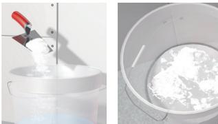
Zum Anmischen pulverförmiger Spachtel wird das Material locker von Hand oder aus dem Beutel bis zur Wasserlinie eingestreut. Die Bildung von Pulverinseln an der Wasseroberfläche zeigt, dass ausreichend Material eingestreut wurde. Durch das lockere Einstreuen wird die Bildung von Klumpen vermieden.
