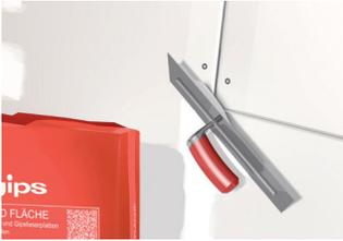
Beim Verspachteln von Gipsplatten wird der Spachtel mittels geeignetem Werkzeug (z.B. Glättkelle) flächenbündig in die Längs- und Querfugen eingezogen, bis die Fugen voll gefüllt sind.
