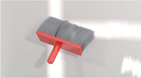
Vor jeder weiteren Beschichtung oder Bekleidung (z.B. mittels Tapete) sind Gipsplattenoberflächen immer vorzubehandeln und zu grundieren. Erst mit einer entsprechend abgestimmten Grundierung (hier empfohlen Tiefengrund) lässt sich die notwendige gleichmäßige Saugfähigkeit und Festigung der Oberfläche erreichen.
