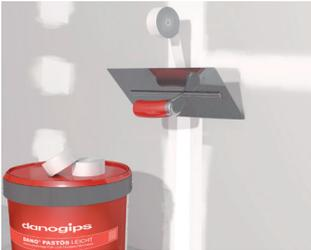
Anschließend wird der Fugenbewehrungsstreifen (z.B. DANO® Papierstreifen) in das noch feuchte Spachtelmaterial eingebettet und mit Glättkelle oder Spachtel glatt eingezogen. Im gleichen Arbeitsgang wird eine dünne Schicht Spachtel aufgelegt. Diese ist dann nach ausreichender Erhärtung fertig für die weitere Bearbeitung.
