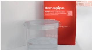
Einfüllen von klarem, sauberem Leitungswasser in einen sauberen Mischbehälter. Verschmutztes oder abgestandenes Wasser sowie unsaubere Mischbehälter oder unsauberes Werkzeug können Einfluss auf die Qualität und Abbindezeit des Spachtelmaterials haben.
