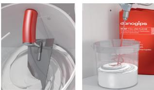
Nach einer kurzen Reifezeit (ca. 3 Min.), kann das Material mit einer Kelle oder einem Quirl (max. 600 U/min.) durchgemengt werden. Durchmischen mit zu hoher Geschwindigkeit kann die Qualität des Spachtels negativ beeinflussen. Längeres Durchmengen verhindert das Bilden einer Wasserhaut.
